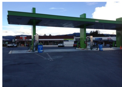
Imagen No. 5: Vista general desde el acceso a la estación de servicio.
