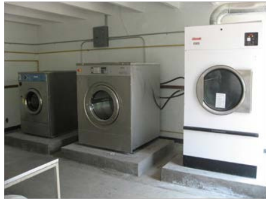
Imagen No. 17: Detalle ubicación de equipos (pedestal) e instalación ductos eléctricos, de gas, agua y ventilación.
