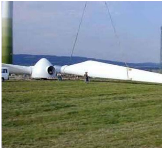
Ensamblaje de las palas en el rotor de un aerogenerador. Fuente: http://nordex-online.com .
