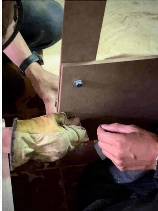
*Tornillos, tuercas y arandelas sujetando los postes a las barandas de la canoa en carpintería.
