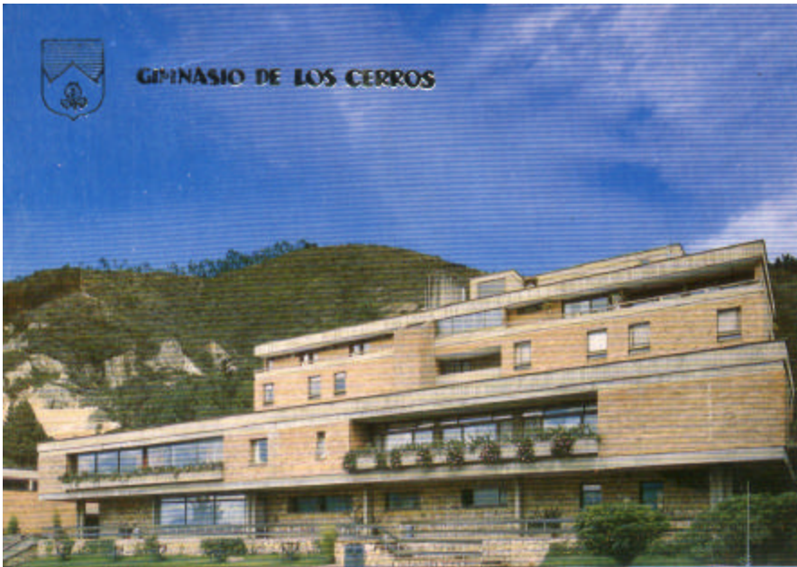
Figura N° 1. Vista de la fachada principal del Gimnasio de Los Cerros.
