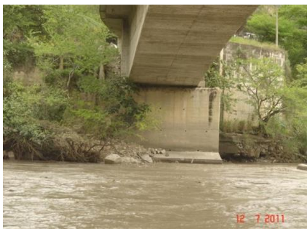
Ilustración 13: Estribo del Puente Pescadero localizado a la margen derecha del Río Chicamocha. (Cusba Morales, 2011)
