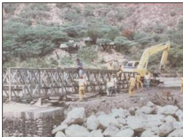
Ilustración 16: Instalación de puente provisional metálico sobre el Río Chicamocha a cargo de la Oficina de Emergencias del Instituto Nacional de Vías. Fuente: (Notivías, Obras de construcción del puente provisional de Pescadero, a cargo de la oficina de emergencias de I.N.V, 1996) (Cusba Morales, 2011)
