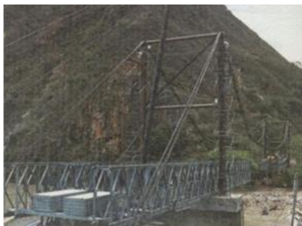
Ilustración 19: El 30 de enero de 1996 se adelantaban labores de construcción del puente provisional colgante metálico. Fuente: (Notivías, 1996). (Cusba Morales, 2011)
