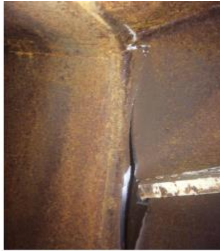
Ilustración 47: Sufrimiento en vigas transversales
