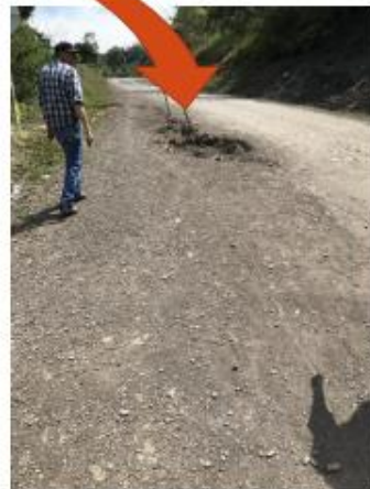
Ilustración 28: Movimiento del terreno por deslizamiento en banca
