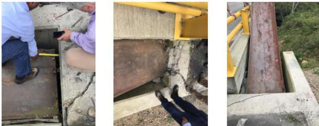
Ilustración 34: Quinta visita arco desplazado aguas abajo e incluido en el estribo
