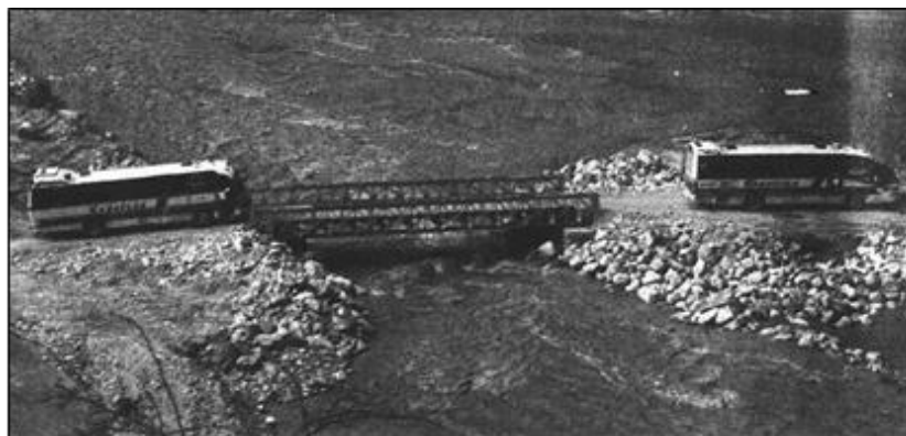
Ilustración 17: Tránsito de vehículos sobre puente provisional metálico con capacidad menor a las 12 toneladas. Fuente: (El Tiempo, 1996). (Cusba Morales, 2011)
