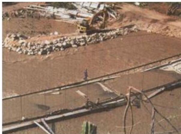
Ilustración 18: El 12 de enero de 1996 comienza la construcción del puente provisional metálico localizado junto al derrumbado Puente Pescadero. Fuente: (Notivías, 1996). (Cusba Morales, 2011)
