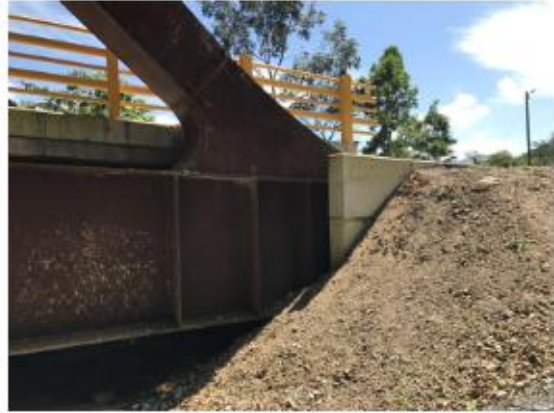
Ilustración 29: Movimiento notorio en la posición del dado provisional para el lanzamiento
