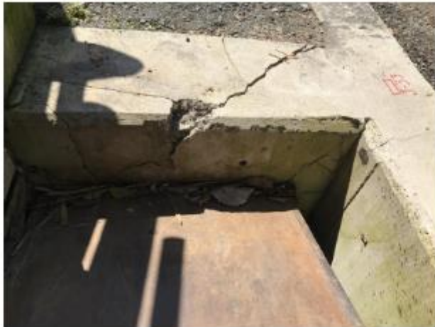
Ilustración 30: Fisura bajo el puente
