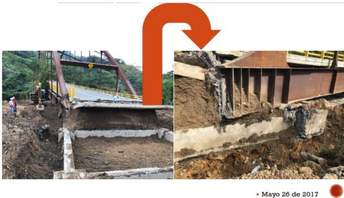
Ilustración 44: Pandeo en rigidizadores
