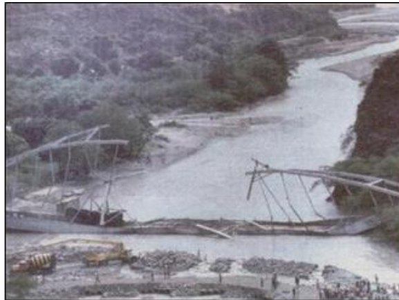
Ilustración 14: Puente Pescadero colapsado el 7 de enero de 1996. Fuente: (Notivías, Puente Pescadero colapsado, 1996).
