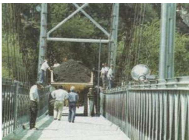
Ilustración 20: El 15 de febrero de 1996 se llevó a cabo la prueba de carga una vez concluida la terminación del puente provisional. Fuente: (Notivías, 1996). (Cusba Morales, 2011)
