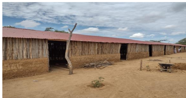
Culminación de la primera etapa de remodelación de la Infraestructura física, Ceir Jorge Mario Aguas Menco, de Juyasirain.
