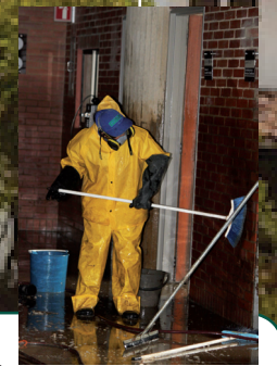
1 de junio: nuevamente se evacua la totalidad del agua, e inicia la rehabilitación del Campus
