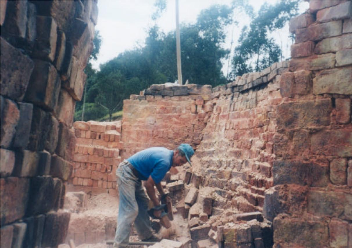
La proporción que se utiliza entre gasolina y aceite es de diez galones de cada uno, para cortar 8000 ladrillos. La mayoría de los hornos de los chircales producen entre veinte mil y treinta mil ladrillos, por cada hornada.
