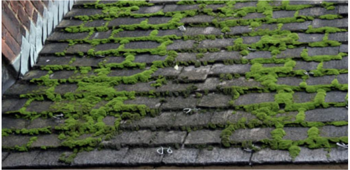
Figura 70. Fotografía How To Remove Moss From A Roof . (Anónimo, s.f)
