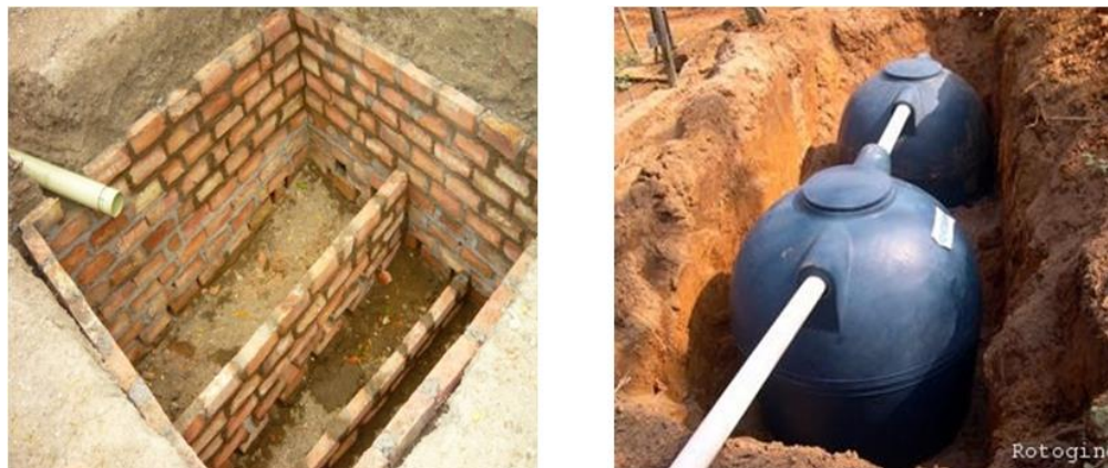
Figura 12 Sistema de tanque séptico tradicional A la izquierda, el tanque fue construido en concreto y ladrillo; a la derecha, el sistema se compone de tanques de polietileno de alta densidad interconectados con tubería y accesorios en PVC Fuente: Tomado de (Ingeplaq, 2016; Rotogine, 2010)
