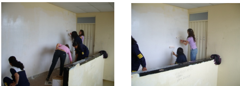
Figura 1. Pintura de paredes. 31 de octubre de 2008
