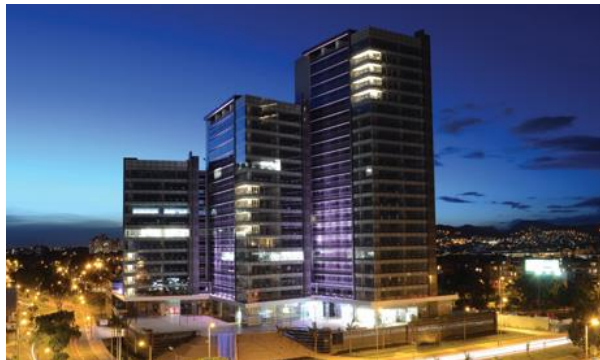
Ilustración 15. Fotografía edificio paralelo 108, Bogotá. Sede física de Media Ambiente Group
