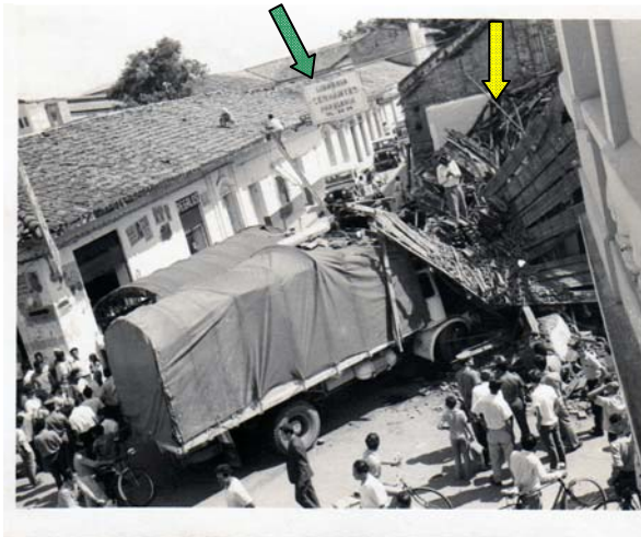
Figura No. 2.8 Fotos del Almacén Singer hace 38 años y de su actual ubicación en la Cra. 5 entre calles 10 y 11.
