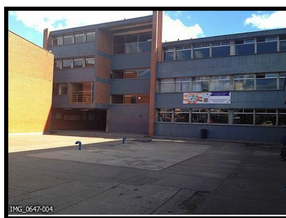
Edificio de secundaria
