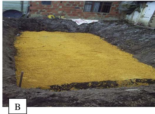
La figura 15. Muestra la excavación realizada para la construcción de los estanques (A). Estanque con un recubrimiento de arena (B). Fuente: Investigador 2012.
