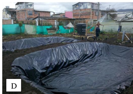
Figura 16. Construcción de los estanques del humedal artificial. Impermeabilización posterior del recubrimiento con arena (C). Estanques con plástico de alta densidad (D). Fuente: Investigador 2012.
