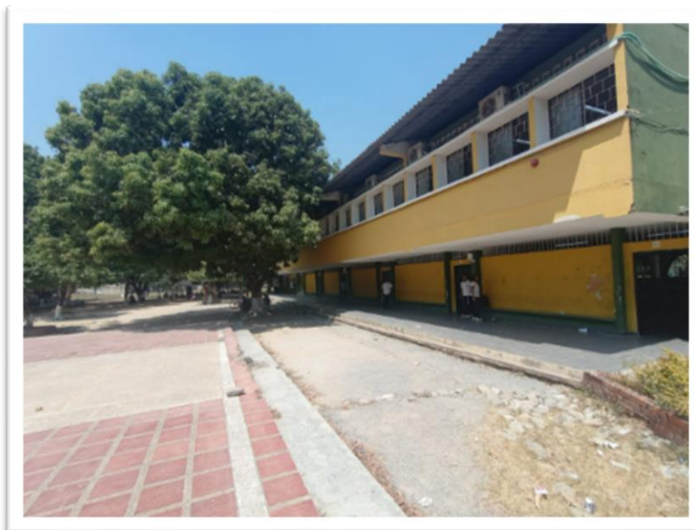
Figura. 6. Fachada Bloque 1 sede principal de la Institución Educativa.
