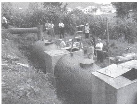
*Biodigestor que recibe desechos de ganado y los transforma en BIOGAS para consumo doméstico.*
