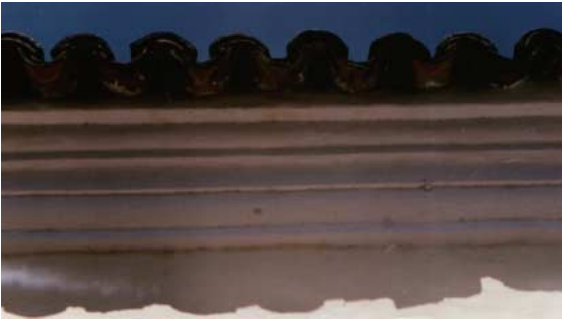
CASA CULTURAL ALFONSO PALACIO RUDAS La cornisa está formada por molduras geométricas compuestas de rectas y curvas.
