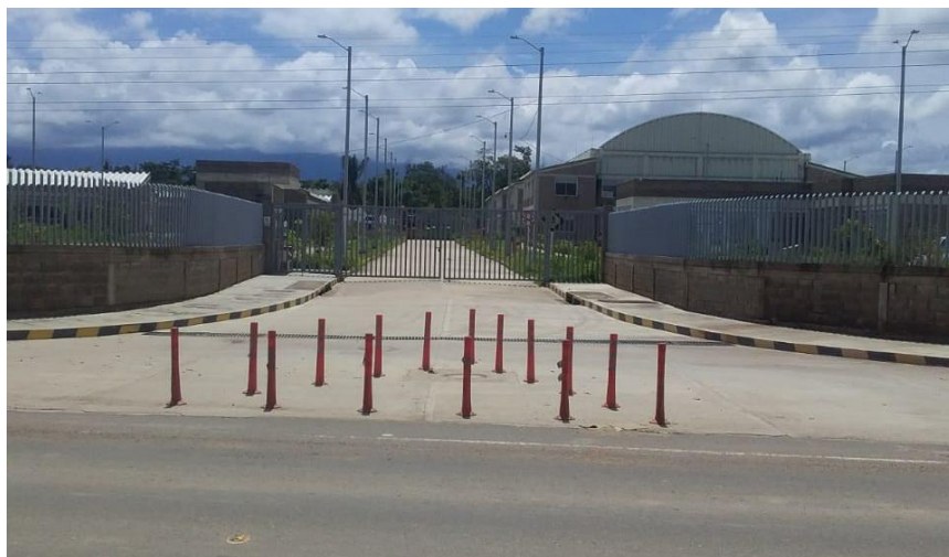
Figura 2 Fachada general de la sede SENA La Jagua de I.. (Fuente: Elaboración propia).
