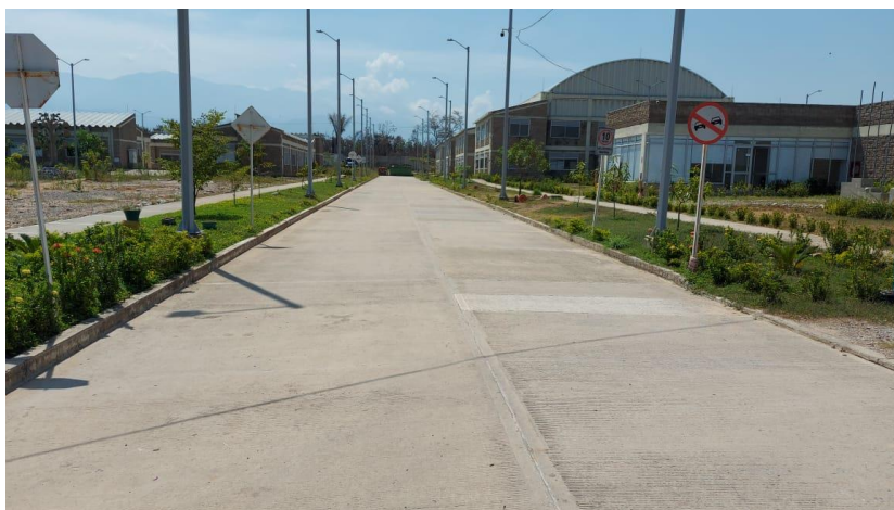
Figura 3 Fachada interna Fuente propia. (Fuente: Elaboración propia).
