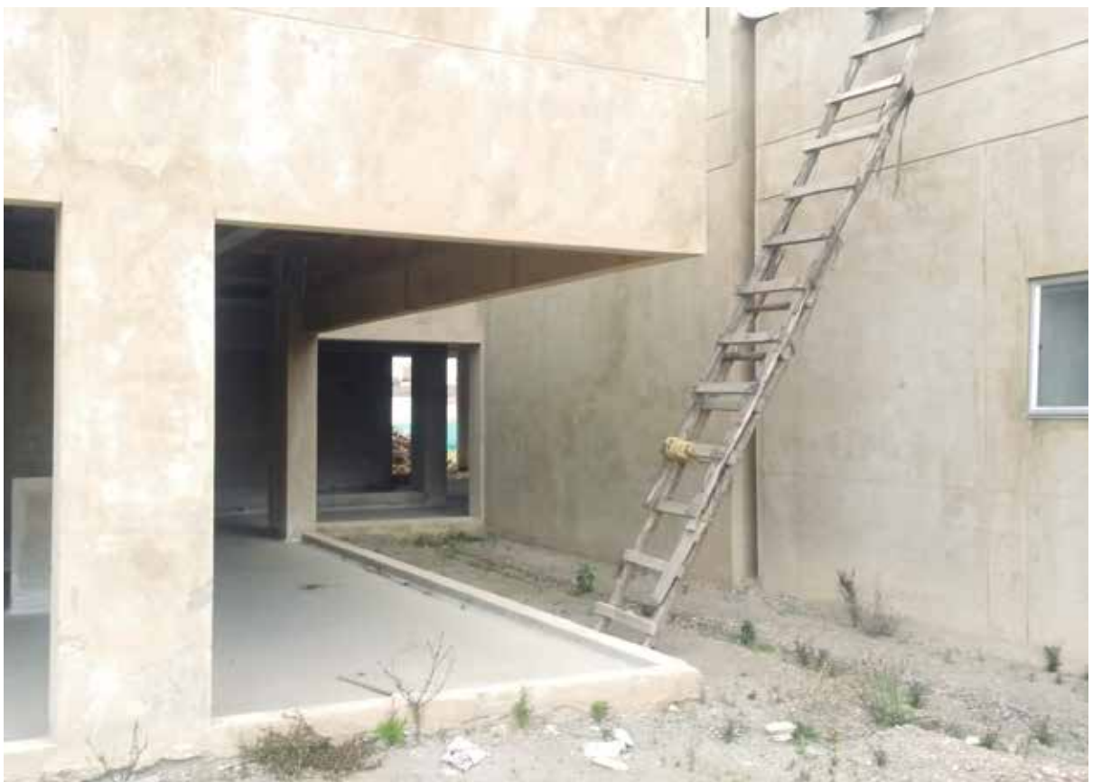
■ Las obras del nuevo hospital registran un 70 por ciento de avance. / FOTO: Angie Alayón.
