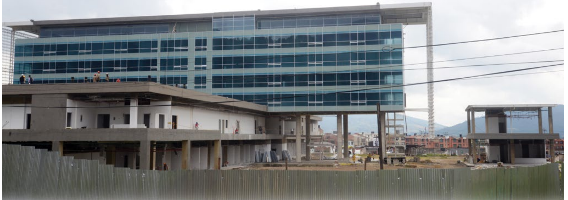
La obra se encuentra adelantada en un 60 por ciento. Se espera que para junio de 2015 esté concluida. / FOTO: DIEGO ROBAYO.
