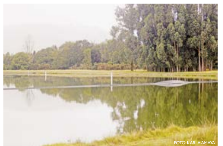
Planta de Tratamiento de Aguas Residuales 2, en Zipaquirá.
