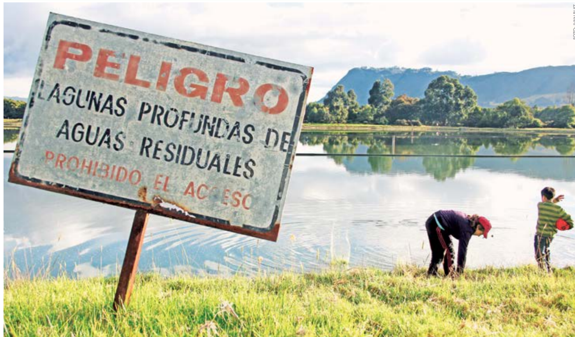
Planta de Tratamiento de Aguas Residuales 2 del municipio de Zipaquirá.
