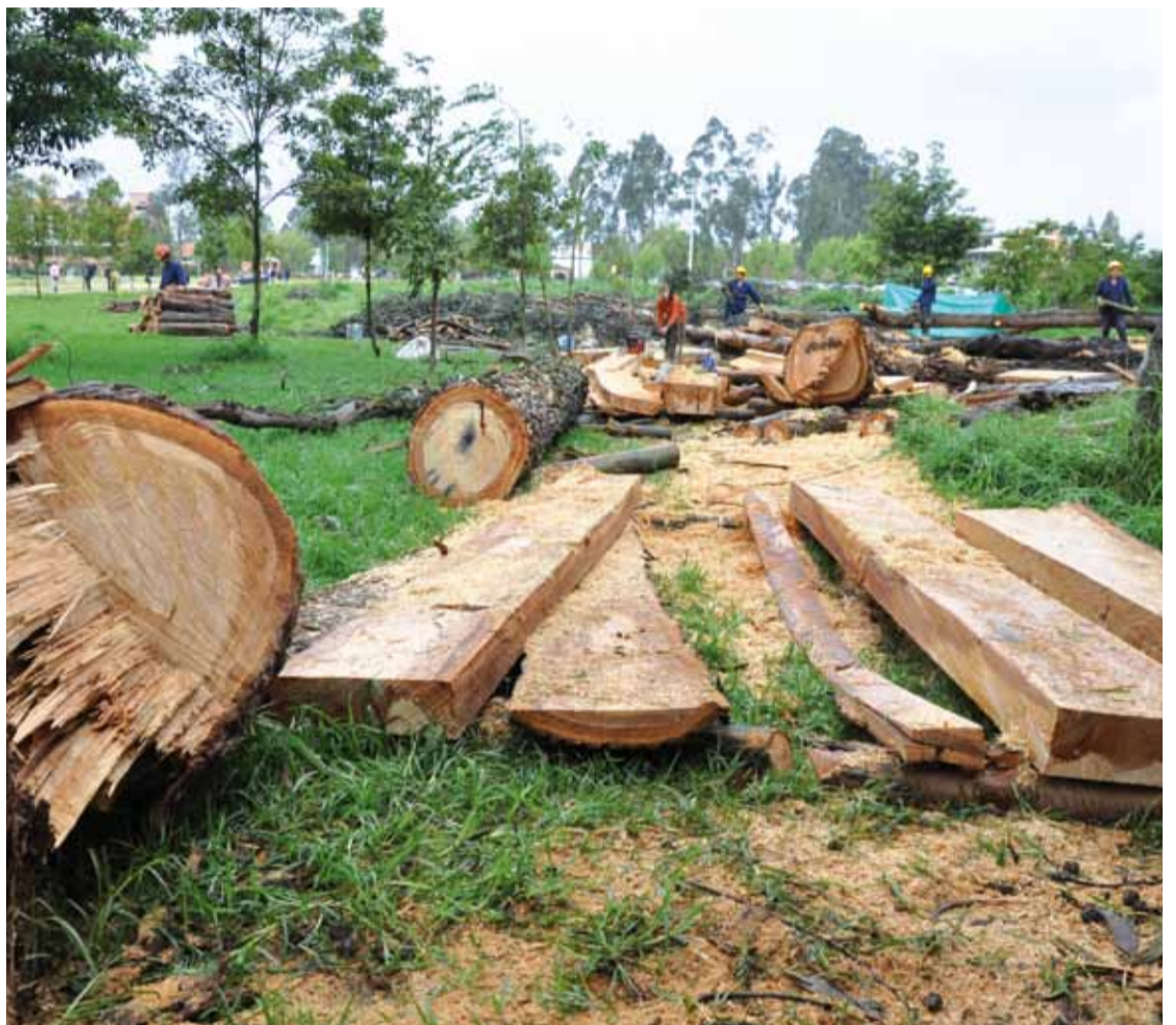
Árboles talados para la ampliación de la vía Puente del Común - Centro Chía.
