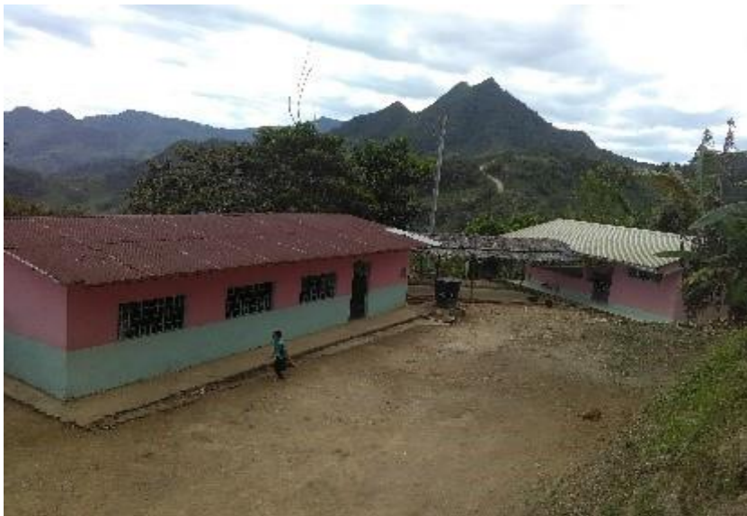
Figura 35. Parte externa de la sede. Fuente: toma propia
