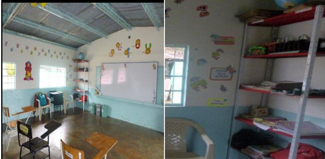
Figura 36. Parte interna del aula. Imagen derecha biblioteca escolar. Fuente: toma propia
