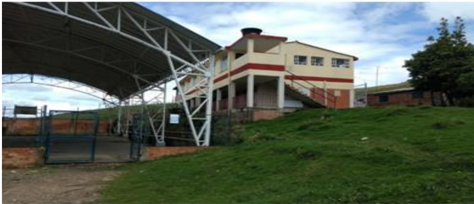
Ilustración 9. Fotografía IEDI. Sutatausa, planta física sede Pedregal. Fuente: los autores (2017).
