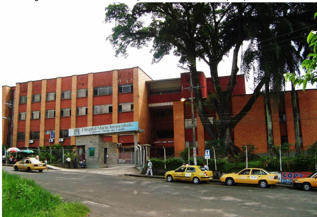
Imagen 1. Fachada E.S.E. Hospital María Inmaculada (HMI), 2014.
