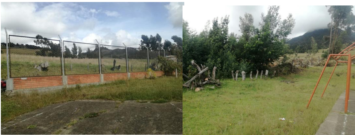
Fotografía 9. Encerramiento de la sede Fuente: Tomada por Autoras
