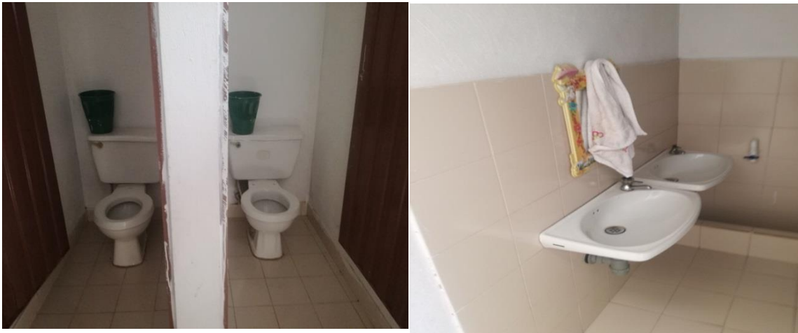
Fotografía 8. Unidades sanitarias Fuente: Tomada por Autoras
