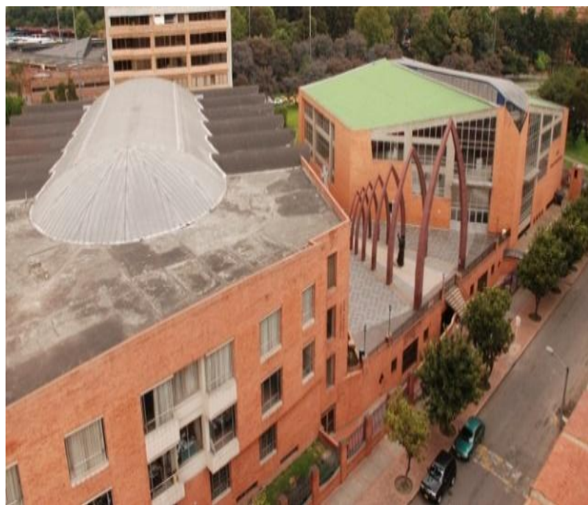
Figura 3 Vista Costado Occidental
