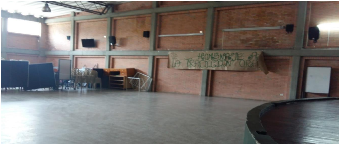
Imagen 17: Aula múltiple del antiguo colegio que no fue demolida en la reconstrucción de los edificios. Ha sido adaptada por la falta de espacio como biblioteca, teatro, patio, gimnasio, sala de audiovisuales, depósito, almacén entre otras.
