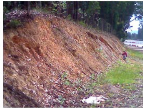
T.C. 4 (Talud control No. 4) Ubicación: Km 1 Vía Duitama – Tunja (Vereda Higueras)
