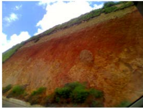
T.C. 1 (Talud control No. 1) Ubicación: Km 2 Vía Duitama – Tunja (Vereda Higueras)
