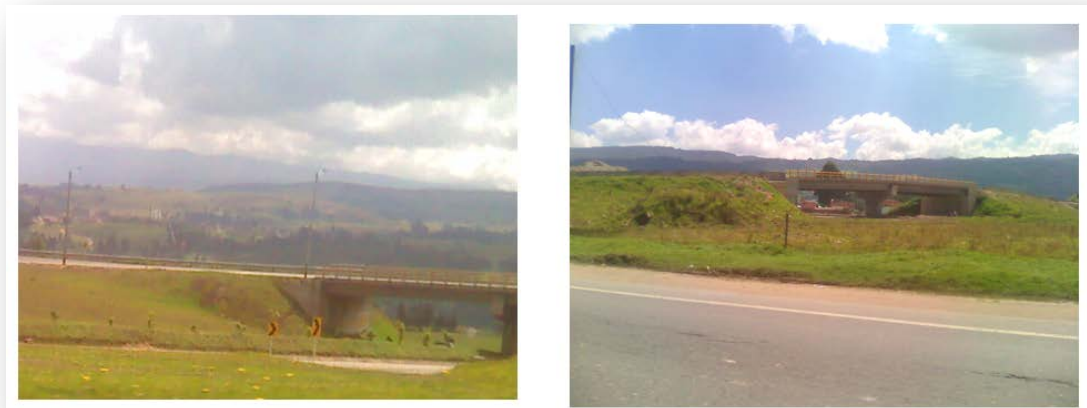
Figura 3. Terraplenes Fuente: Autor
