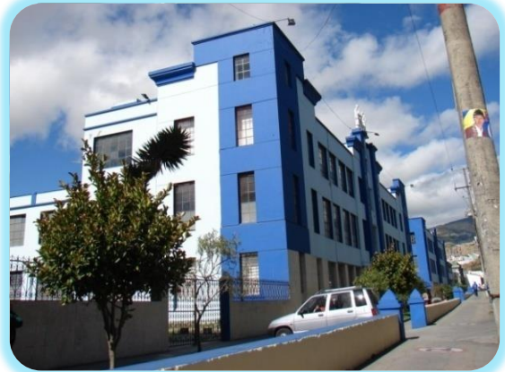
Imagen 2. Fachada exterior I. Champagnat
