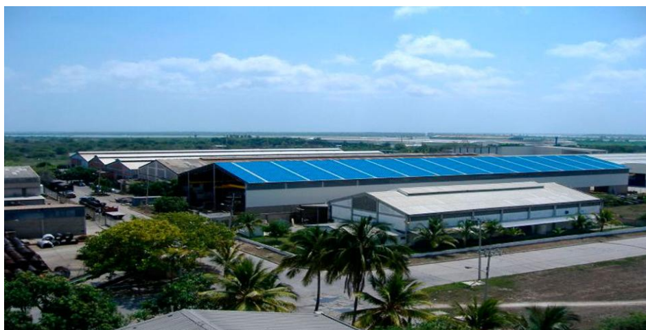
Figura N° 37. Instalaciones de Quimifer
