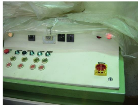
Imagen 23. Tablero de control.
