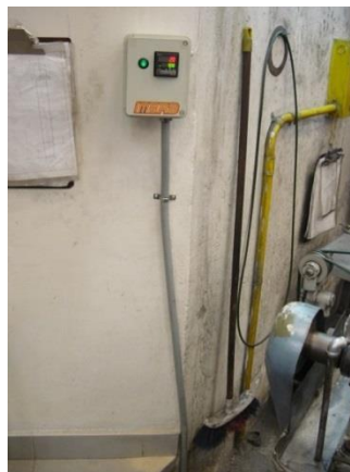
Imagen 28. Contador instalado y funcionando
