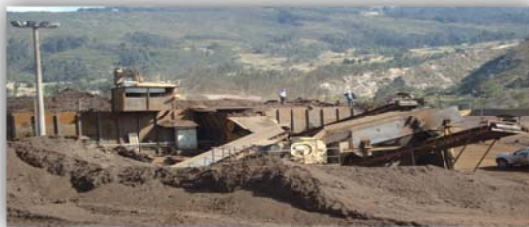
Figura 3. Planta de trituración de Mineral de Ubalá instalada en Octubre de 2008.
