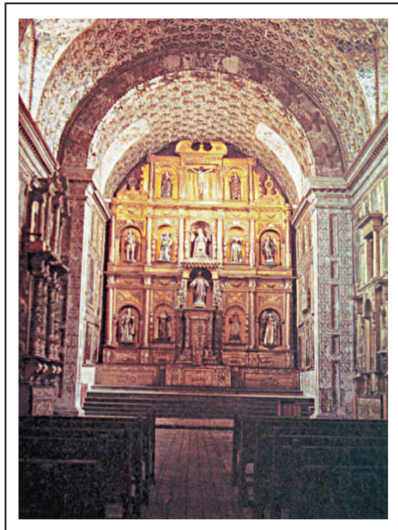
La arquitectura Basílica se caracterizó por la cubierta en forma de bóveda de cañón corrido. Interior Iglesia Santa Clara, Bogotá Zona Histórica.
