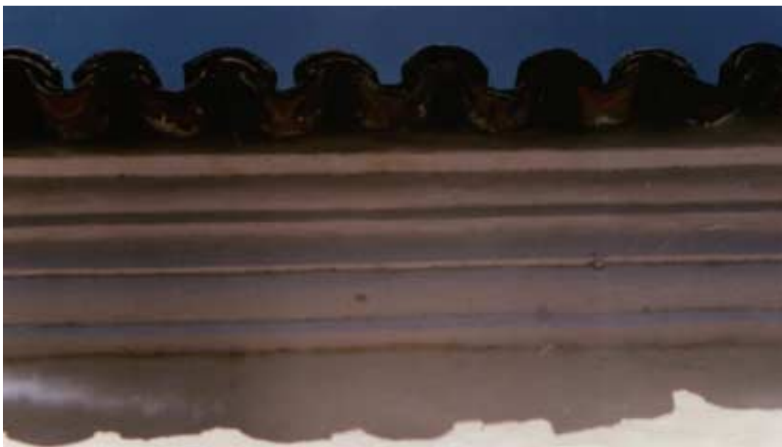
CASA CULTURAL ALFONSO PALACIO RUDAS La cornisa está formada por molduras geométricas compuestas de rectas y curvas.
