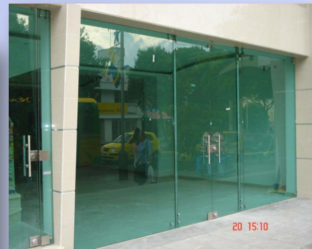
En tubo de acero
