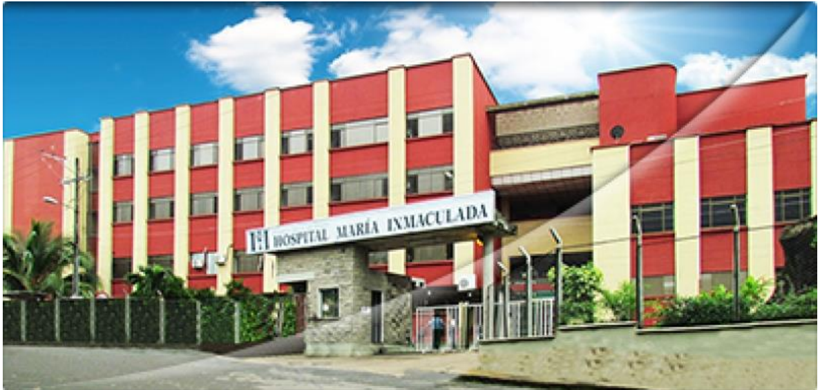
Imagen 1. Fachada E.S.E. Hospital María Inmaculada (HMI), 2014.
