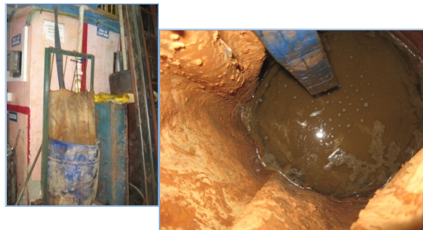
Figura 11. Descarga de lodos
