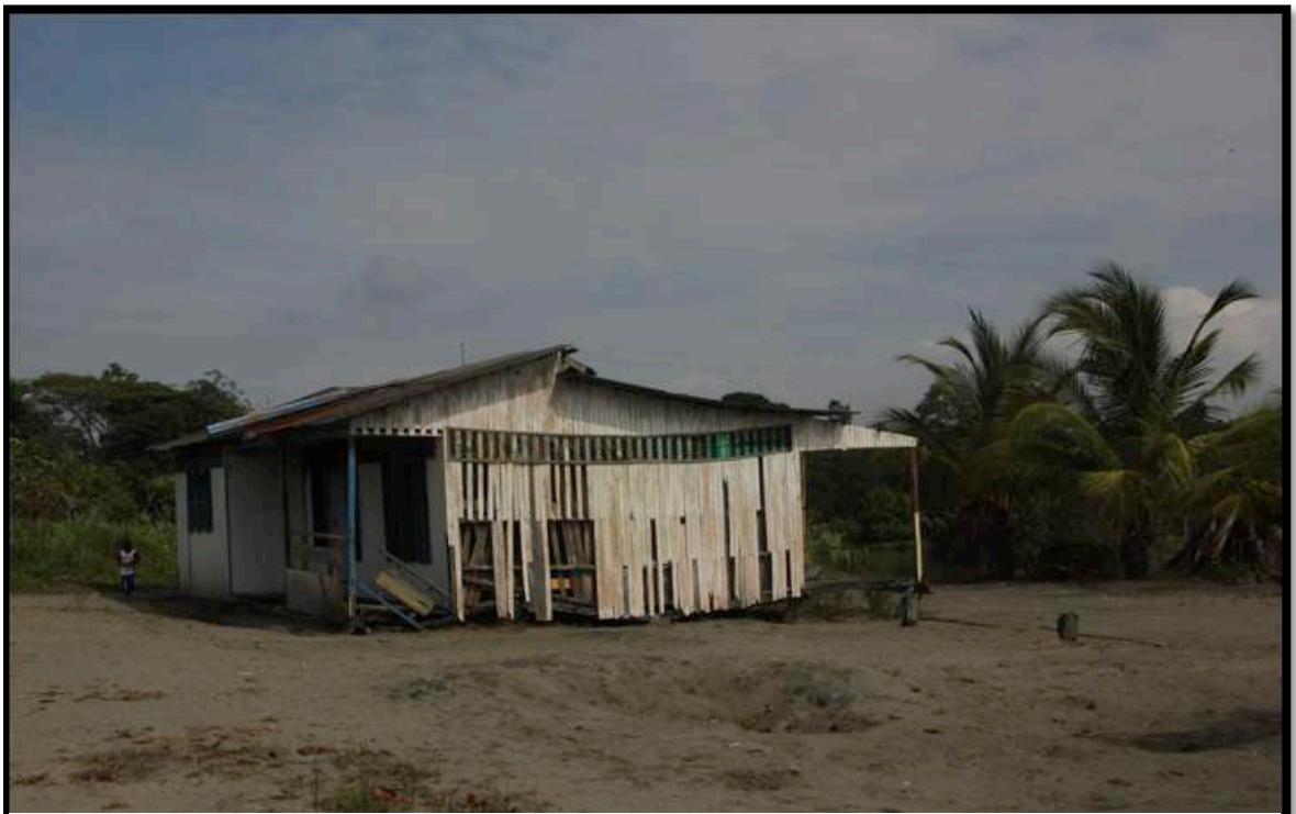
Parte de las instalaciones del Hotel Las Lilianas en Bocagrande
