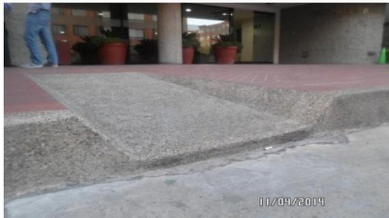
Este edificio cuenta con rampa de acceso a la entrada principal, diferenciada en textura y pavimento, con una inclinación adecuada.
