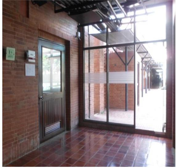
La salida del edificio C que se articula con el edificio B, presenta la mínima dimensión en ancho, indicada para el paso de una persona simultáneamente, lo cual sumado al desnivel que presenta la convierte en una salida poco adecuada en situaciones de emergencia, sin contar que hayan usuarios en silla de ruedas.
