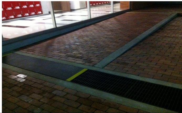
Las rampas de acceso a los edificios son de dimensiones adecuadas y se observa la protección para las rejillas de desagüe, que evitan que las llantas de las sillas de ruedas queden atascadas en las mismas. Falta señalización de rampas (SIA)
