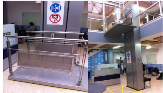
El edificio no cuenta con rampas para ir de un piso al otro. En su lugar hay una plataforma de traslado vertical. Una característica negativa es por ejemplo la ausencia de una barra de contención en uno de sus extremos, lo que claramente es un riesgo para los usuarios.
