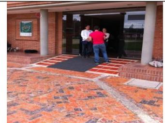
La rampa ubicada en la entrada principal al edificio, tiene las dimensiones e inclinación adecuada para su uso, sin embargo, no tiene la señalización requerida (SIA) y debería estar complementada con escaleras que en ocasiones son más fáciles de utilizar que las rampas, por parte de personas con limitaciones motoras que por ejemplo, requieren del uso de muletas.
