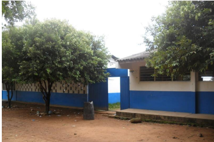
Entrada Principal de la Institución
